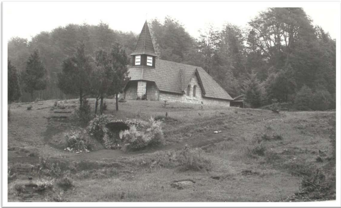
Capilla La Asunción, construida por Parques Nacionales en 1936.
