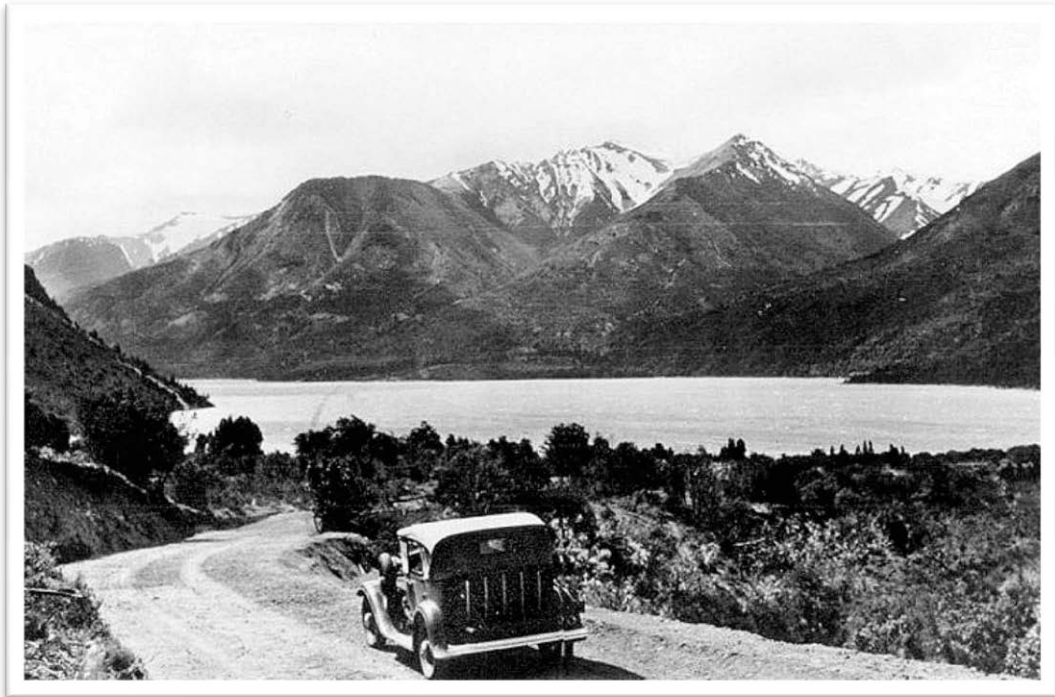
Camino a Bariloche finalizado en 1935 realizado "a pala" por los pobladores.
